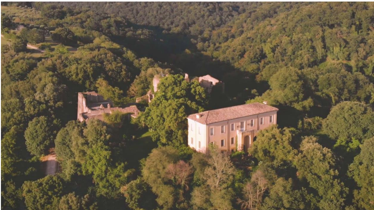
Granaio dalla famiglia Borghese ristrutturato, e castello del XII secolo.
